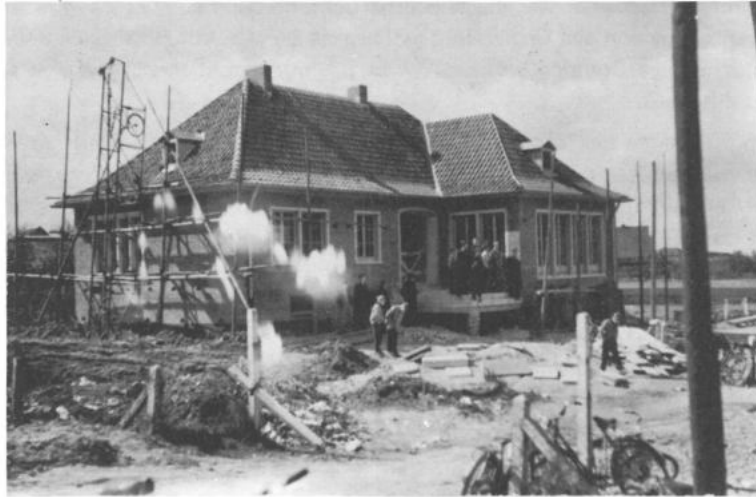
Das Kreissporthaus im Bau. 1956 wurde es fertig.
